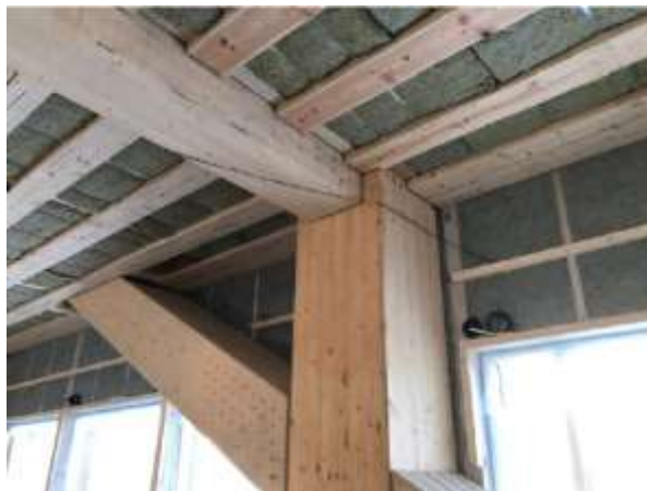
Рис. 8 Узел примыкания перекрытия к стойке и раскосу
